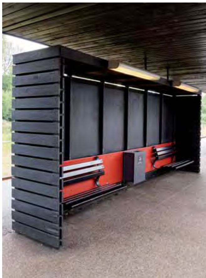
Perronoverdækninger og læskur på Skanderborg station, der viser elementer af Sten Zincks modulsystem. (BP)
